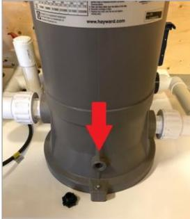
Remettre le bouchon de drainage à la base du filtre à cartouche.
