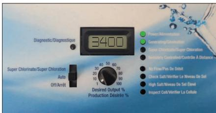
Les 2 premières lumières vertes indiquent que le système au sel est fonctionnel. Le système au sel produit du chlore.
