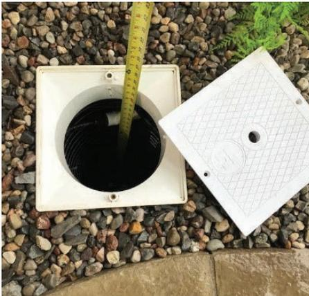
**Vérifier la hauteur de l'eau dans le puits d'assèchement :**
