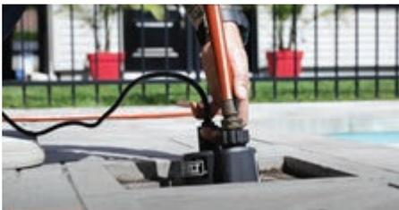
**Si nécessaire, videz le puits d'assèchement avec une pompe submersible.**
