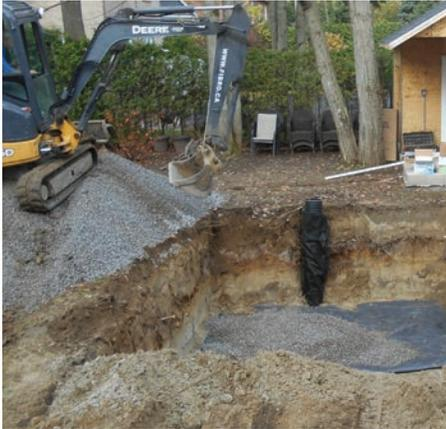
**Si nécessaire, videz le puits d'assèchement avec une pompe submersible.**
