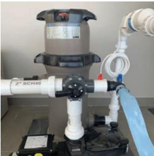
Adapter le tuyau de drainage (tuyau bleu).
