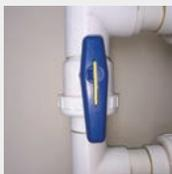
poignée suivant le sens de la tuyauterie = valve ouverte
