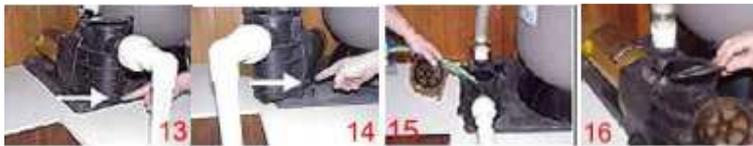
7. Placer la valve de succion (au niveau de la pompe) et la valve de retour **en mode piscine**.
